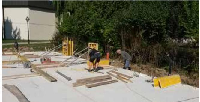
Die Hälfte der Säulen, auf die der Dorfstadel aufgesetzt wird, sind schon fertig. Dazwischen werden noch die Sockelmauern hergestellt und nach dem Nussfest soll mit dem Aufbau der Holzkonstruktion begonnen werden.
